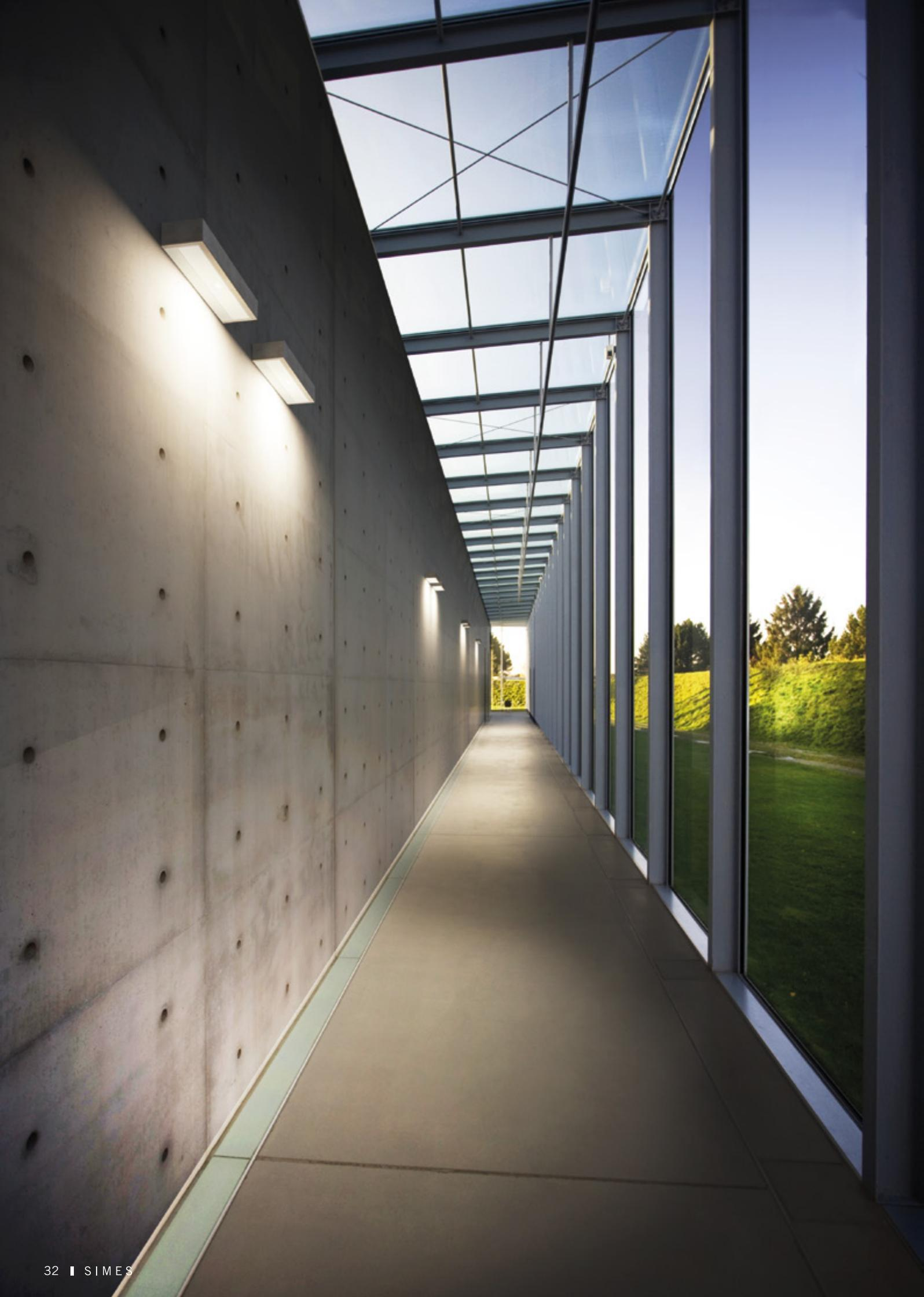
Rivestimento in cemento con aggiunta di fibre sintetiche ad elevate resistenze meccaniche.
